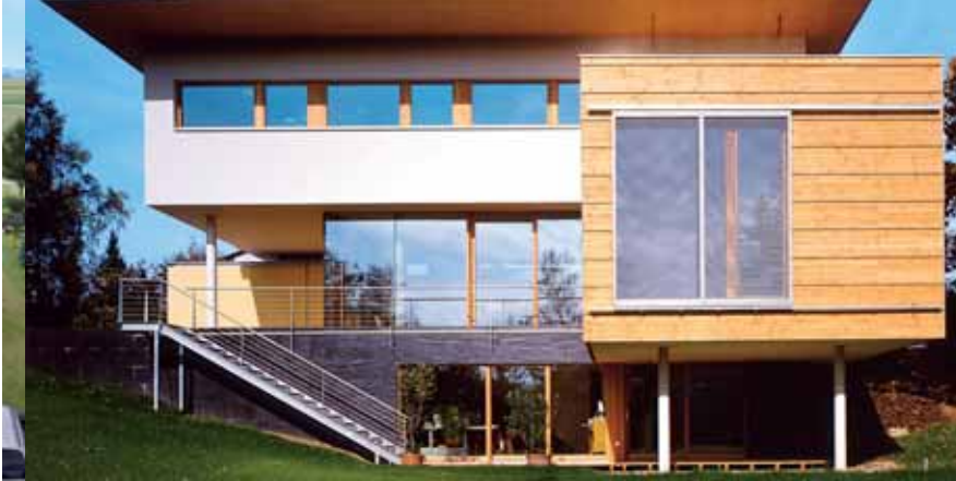
Pasívny dom Proyer, Architekti Proyer & Proyer Steyr, Rakúsko
